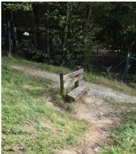
Foto Punkt c) Marode Bank – Beseitigung wurde bereits früher beantragt, auch via Mängelmelder – bislang ohne Erfolg!
